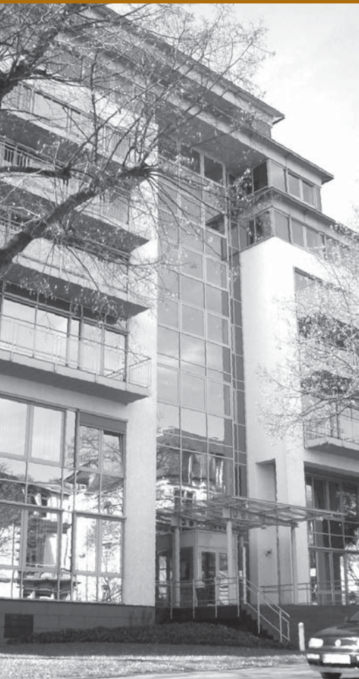
→ Das Bildungshaus Bad Nauheim
